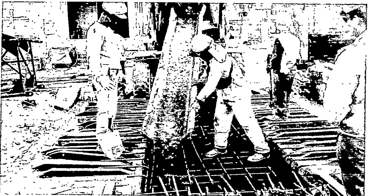
PREPARACIÓN Y VACIADO DE CONCRETO
