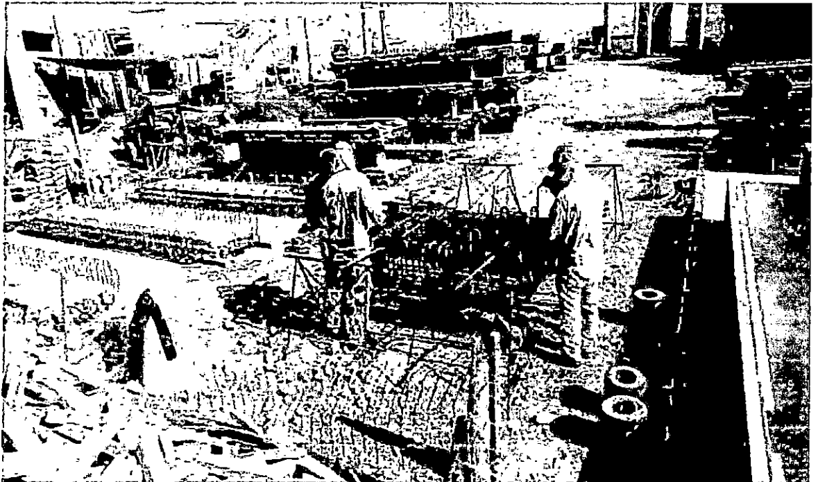
HABILITADO Y CORTADO DE ACERO
